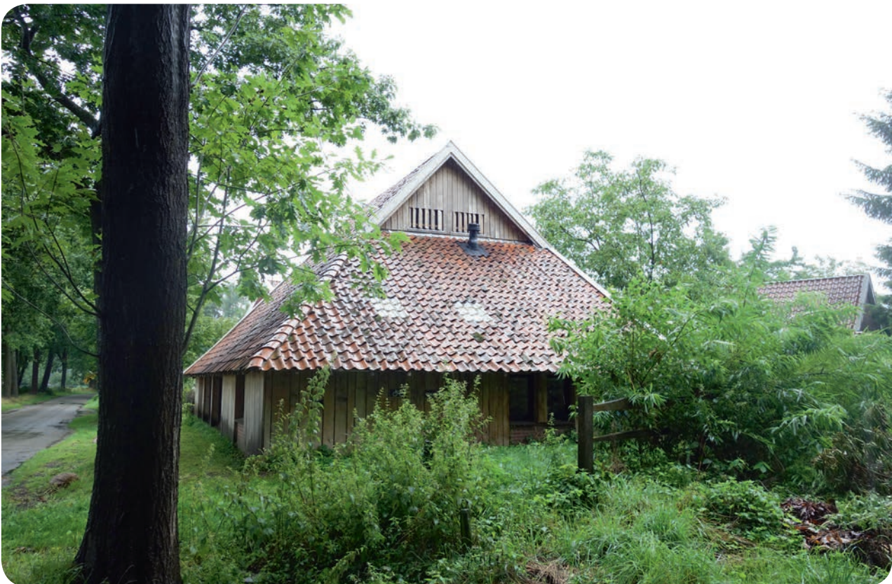
Buitenaanzicht van De Schoppe
