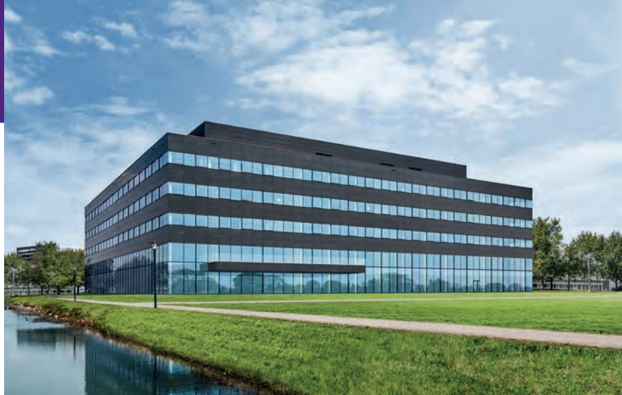
Het Danone Innovation Centre in het Utrecht Science Park scoorde een BREEAM-NL 'Excellent'.
