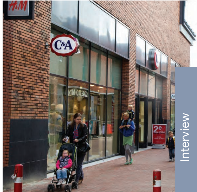
Het Mercurius Center in Assen stamt uit 1980 en is aangepast door onder meer het oude dak en de gevels te verwijderen. Ook is er hoogwaardig isolatiemateriaal aangebracht.
